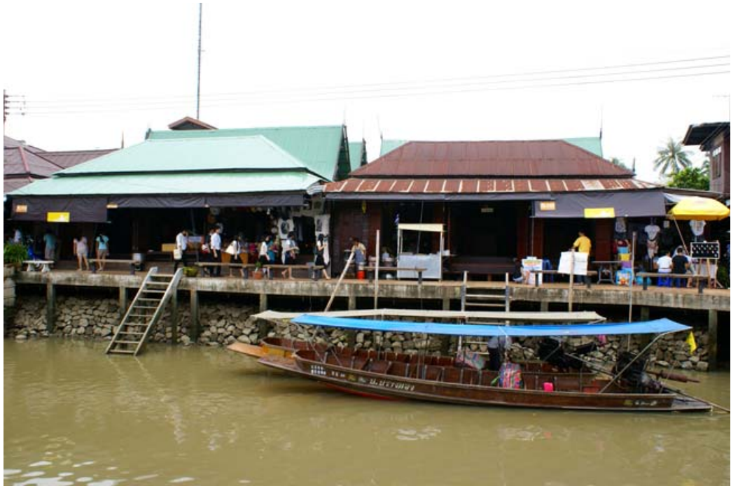
ภาพที่ 8 ตัวอย่างของอาคารริมคลองอัมพวาที่ได้รับการบูรณะตามรูปแบบอาคารเดิม
