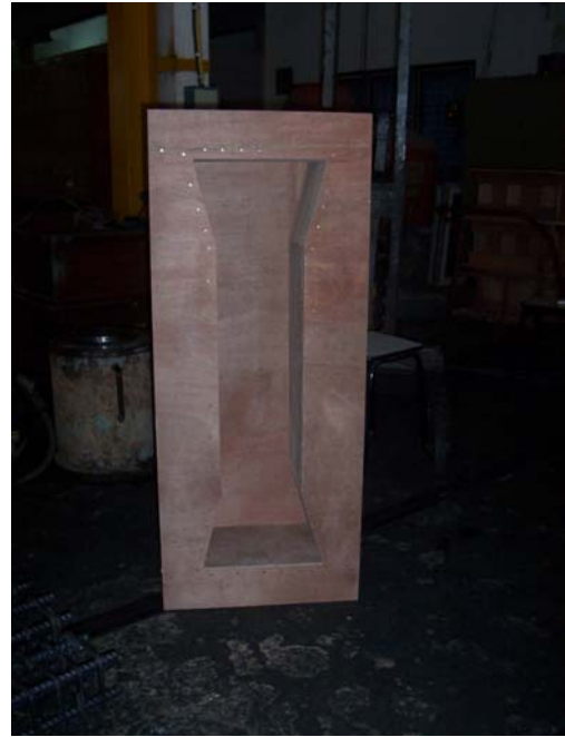
รูปที่ 2 ไม้แบบที่สร้างเสร็จจริง
