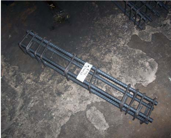
รูปที่ 1 ภาพเหล็กที่ผูกเสร็จแล้ว
